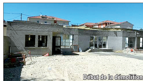
Début de la démolition
